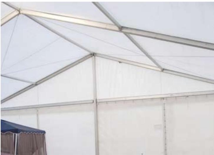
**Lonas** con trama interior de poliéster, con inducción de P.V.C. y resistencia al fuego de M2 por composición. Las lonas están sometidas a tratamiento anti-rayos UVA, anti-moho, anti-pútrido y anti-ambiente salino. Así mismo llevan un barniz anti polvo en su cara exterior. El resultado de esta operación es una lona totalmente impermeable, indeformable y muy resistente.
